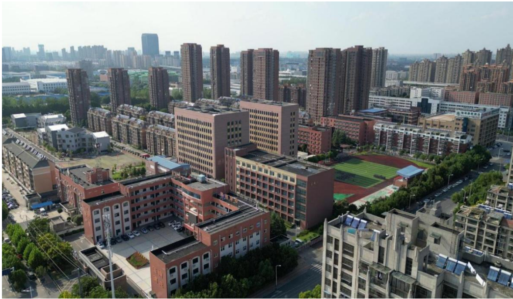
图 2 庐州卫生科技学校俯瞰
